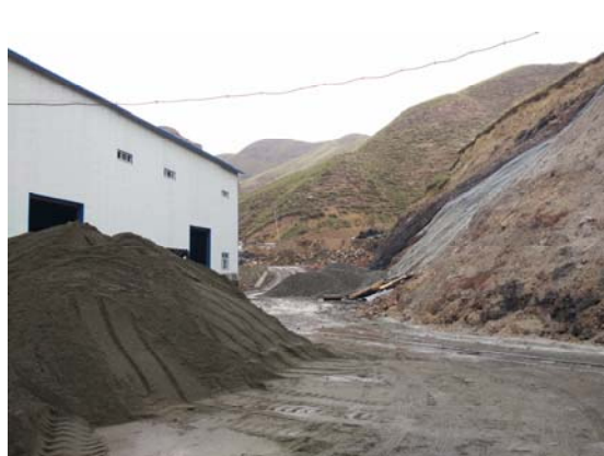
原地拆除后新建机修间
