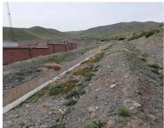
照片 2-6-4 爆破器材库防排水工程
