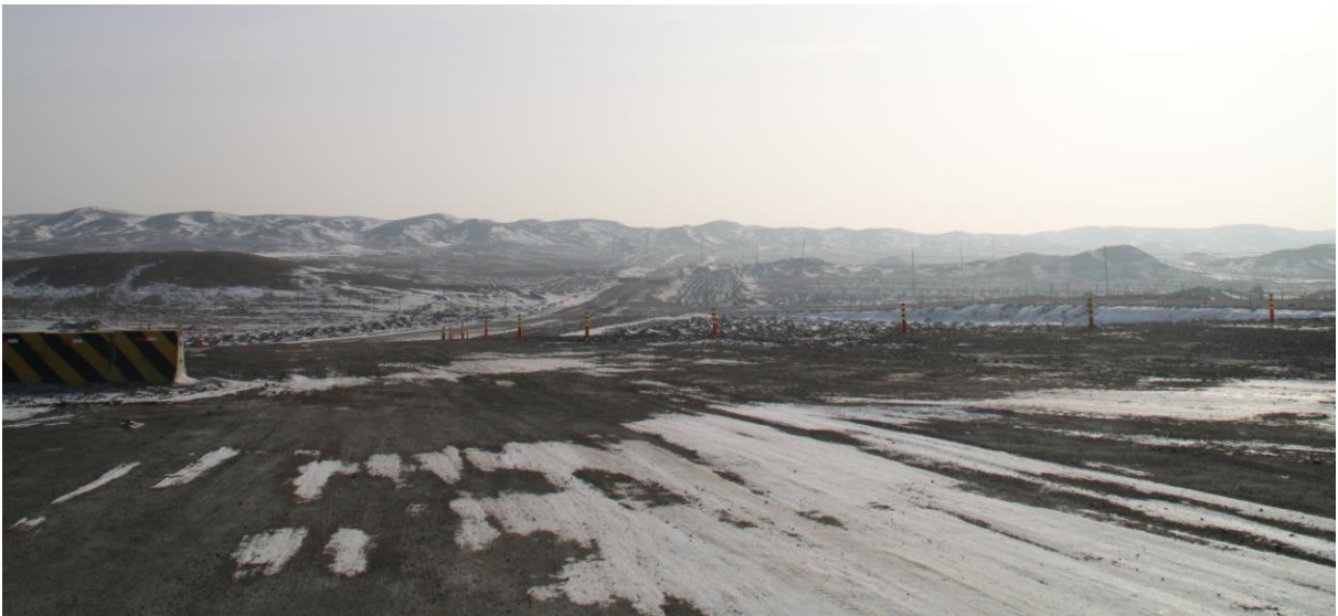
图 3-2-8 露天矿东侧沟谷影像资料
