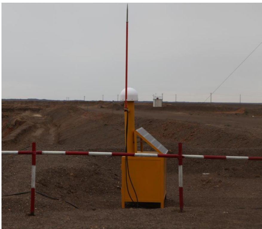
图 5-6-3 自动化边坡监测设备影像资料
