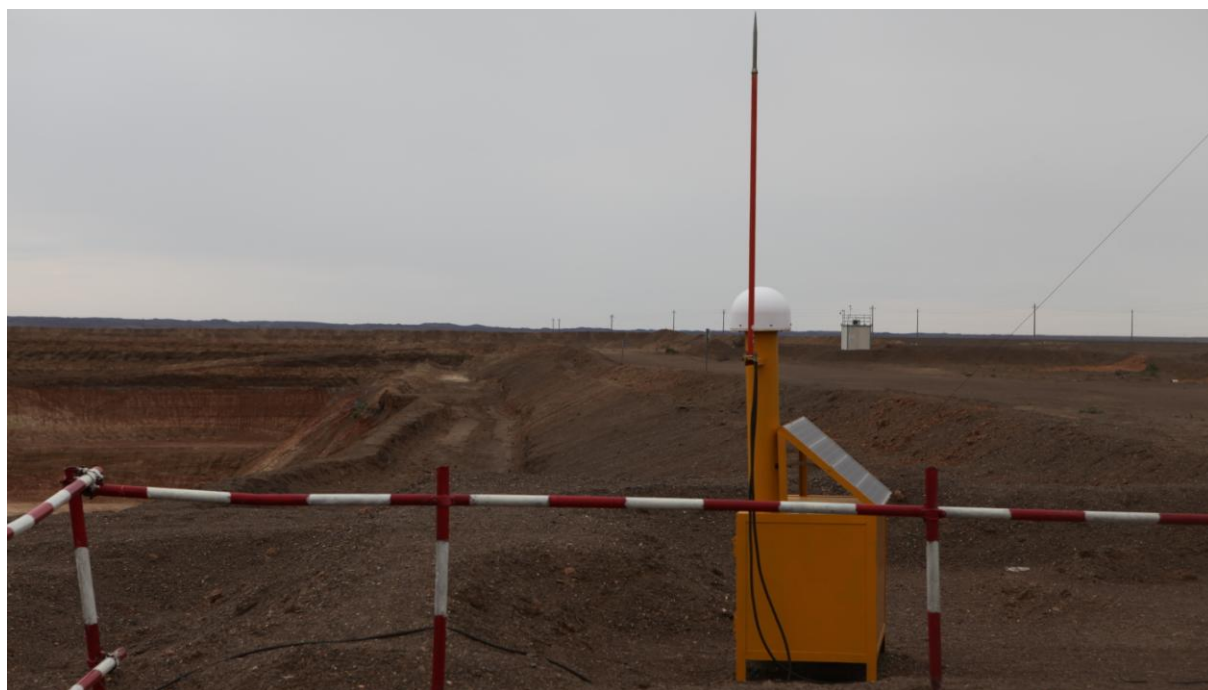
图 2-6-4 边坡监测系统可移动式监测站
